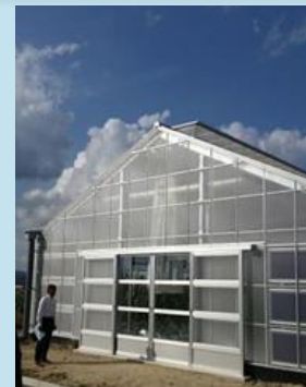
【実証ビニルハウス】
