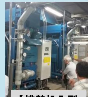
【排熱投入型 冷温水機】
