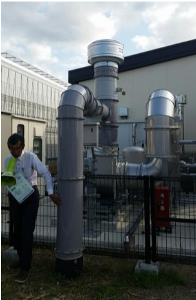
トリジェネレーション システムの紹介
