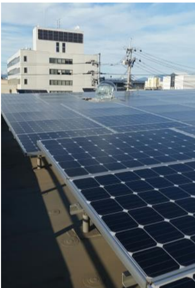
店舗屋上の太陽光パネル
