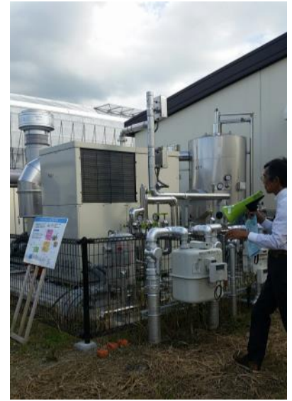
トリジェネレーション システムの紹介
