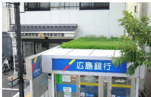
<エアコンの余剰水を活用したメンテナンスフリーの緑化システム施工例>
