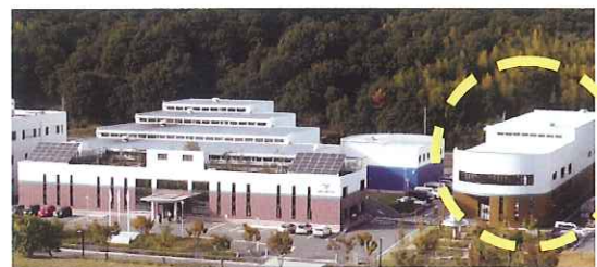
日本伸縮管(株)ニューロンラボ全景 右側がC棟
