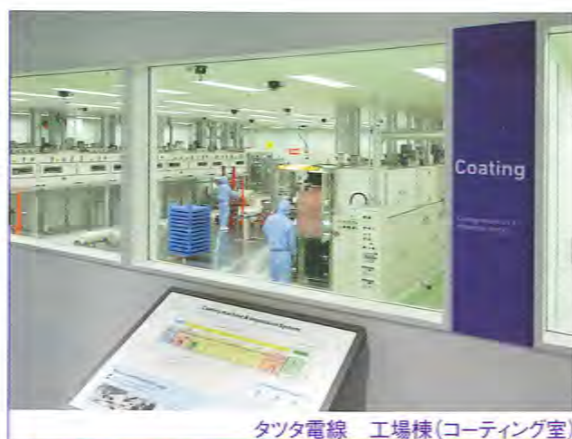
タツタ電線 工場棟(コーティング室)
