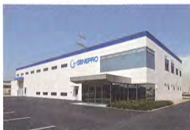
完成した新本社工場
