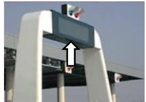
ETCゲートの下部（矢印）が反射の原因となるため、この部分に電波吸収パネルを設置
