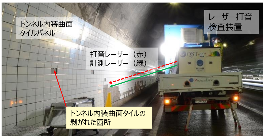
写真1 トンネル内装曲面タイルパネルにおけるレーザー打音検査状況
